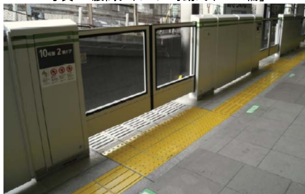
写真2 腰高タイプの「可動式ホーム柵」
